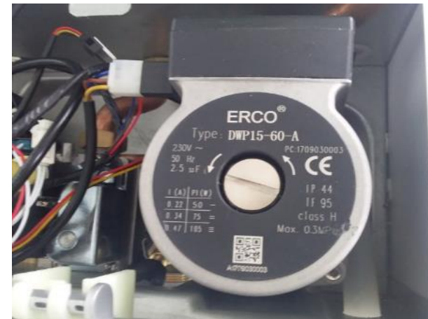
Циркуляционный насос ERCO 3 скорости, не усеченный корпус DWP 15-60
